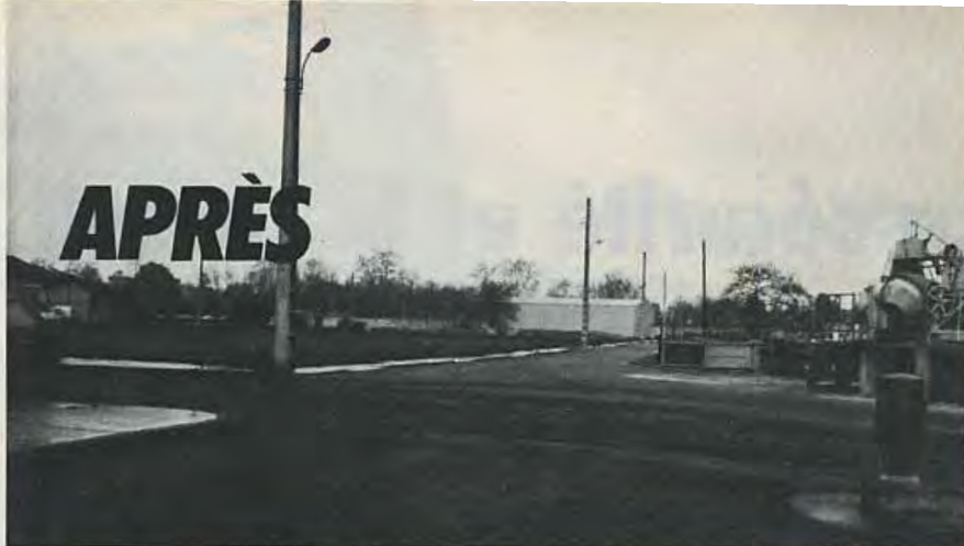
Emplacement libéré par la démolition Nord-Ouest de l'A.T.E.
